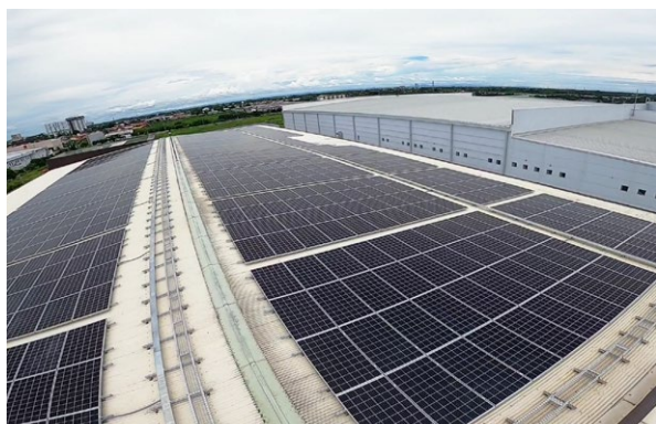
太陽光パネルの設置
